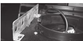
2. Установка вытяжки. Закрепите вытяжку на крепежной пластине при помощи крепежа, поставляемого в комплекте. Убедитесь, что все крепежные элементы зафиксированы.
