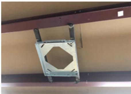
3) Данную конструкцию закрепите на потолке. Используйте стальные дюбеля М8.
