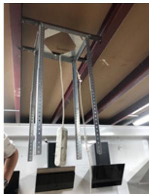
4) Отрегулируйте высоту телескопических крепежей так, чтобы расстояние до варочной поверхности было не меньше допустимого и закрепите их при помощи шурупов 3,9\*9,5.
