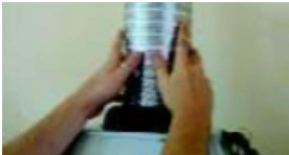
4. Подключите алюминиевую трубу к вытяжке (адаптеру). Алюминиевая труба должна быть надежно закреплена.
