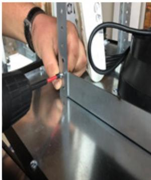
7) Соедините вытяжку с телескопическими крепежами и зафиксируйте соединение при помощи саморезов.
