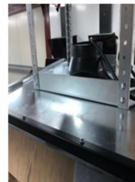
8) Установите гофру воздуховода на адаптер воздуховода и закрепите соединение хомутом.
