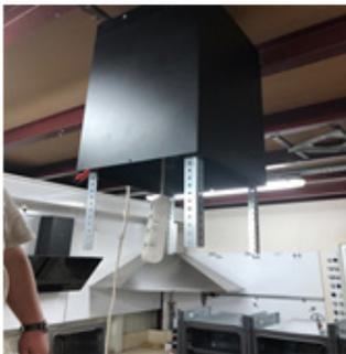
6) Установите верхний короб (с прорезями) и зафиксируйте при помощи шурупов 3,9\*9,5.
